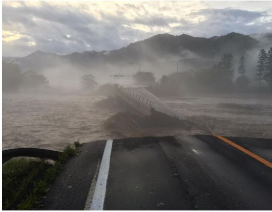
図-1 国道 274 号日高町千栄-清水町 (H28.8.31)
