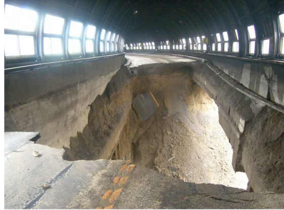
図-2 国道 274 号 日高町三国の沢覆道 (H28.9.8)
