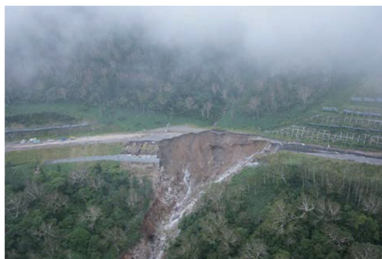
写真-1 国道 274 号日勝峠 7 合目付近の崩壊の様子(北海道開発局帯広開発建設部提供 (H28.9.2 撮影))
