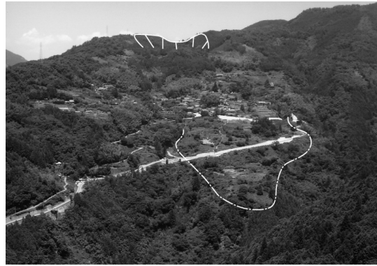
図6 尾根に滑落崖、斜面中腹に末端をもつ活動的な付加体地すべり(高知県吾川郡いの町打木地すべり)
