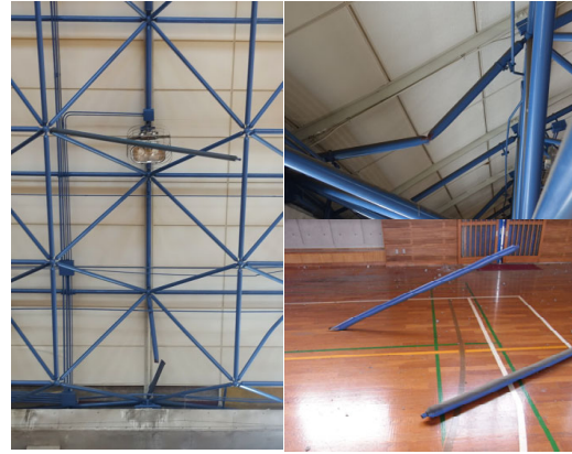
図 1 2016 熊本地震の被害例(A 高校体育館)
