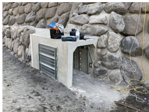
図-5 観測用ボックスカルバート
