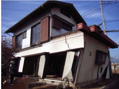
写真3 1/2.5 rad を超える大変形
