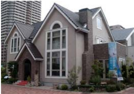
写真1 供試した枠組壁工法住宅の外観
