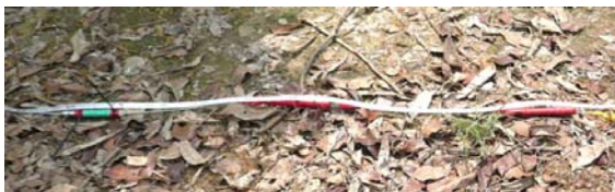
図4. 温度計の取り付け状況。
