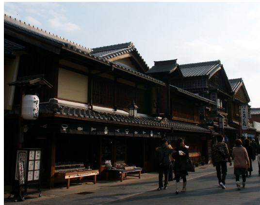
図6 屋外広告は1階軒下の暖簾と屋根下の突出広告に統一され色も限定されている
