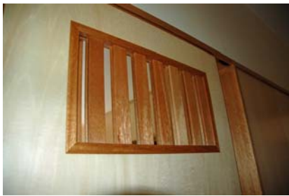
写真1 居室間の引き戸に設置されたスリット
