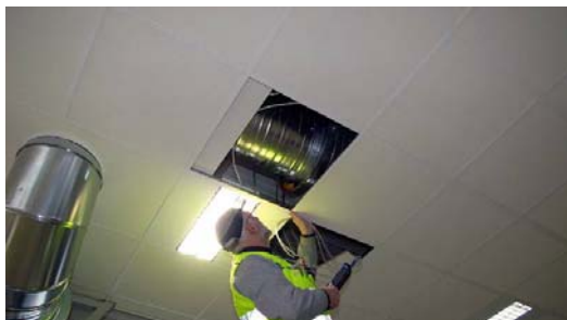
写真6 スウェーデンにおける換気空調設備の現場における性能検証（k-factor 法による測定）
