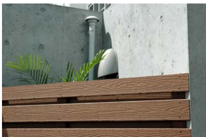
写真3 深型外部フードが外部風のあたりにくい場所に設置されている例
