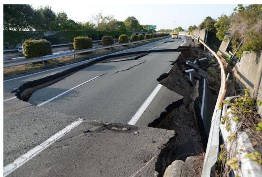
図-2 地震による高速道路盛土の被害 (熊本・九州自動車道、2016年)
