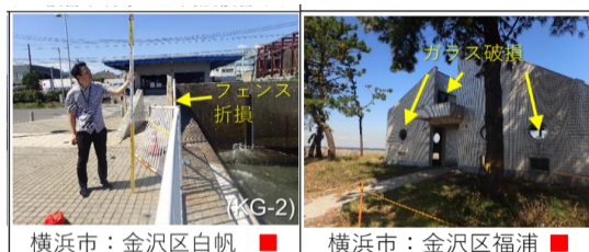
図-4 横浜市金沢区の高波被害
