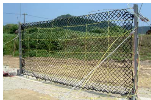
写真1 ポリエチレンネット製落石防護柵
