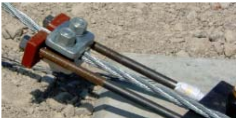
写真2 緩衝装置(上:クリップ型, 下:金具型)
