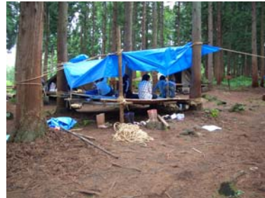
図9 完成した森小屋
