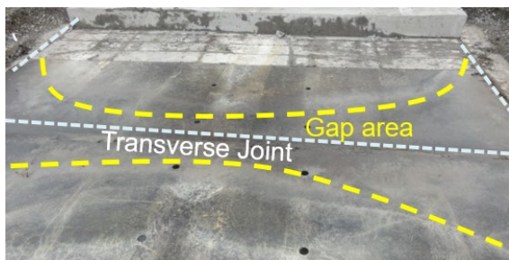
図 9 アスファルト中間層表面の状況
