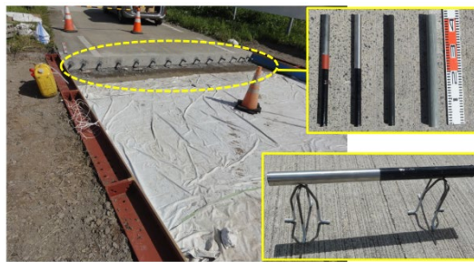
図 10 腐食性ダウエルバーによる補修
