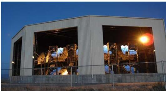
図2: TAの大気蛍光望遠鏡ステーション。アレイの周りに3つのステーションを置いて内側をみこみ、アレイに入射した空気シャワーの発達を撮像する。
