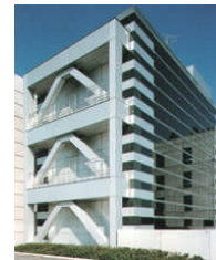
写真1. 可変剛性建物
