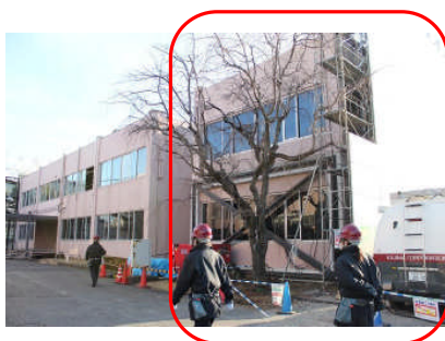
写真2. 鹿島建設技術研究所 8号館増築棟
