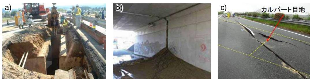
図1 アンダーパスにおける段差・目開き被害：a) 2004年新潟県中越地震<sup>1)</sup>における目開き，b) 2011年東北太平洋沖地震<sup>2)</sup>における目開きと土砂流入，c) 2016年熊本地震<sup>3)</sup>の段差被害
