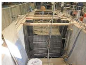
写真-1 Case1-実験後(崩壊)
