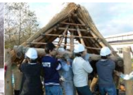
写真2 チセブニの様子 チセブニ（アイヌ語）とは、地上で組み立てた屋根を持ち上げ、柱の上に載せることをいう。多くの人手が必要なこの作業時には、総勢30名の学生が参加した。
