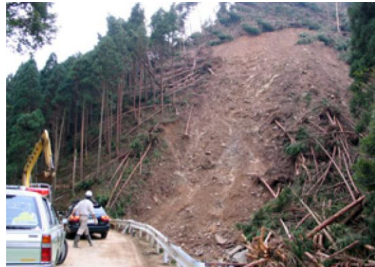
図1 2004年台風23号による風倒木と斜面崩壊 1)
