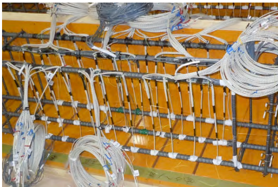
熱電対配置状況
