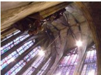
イスラム建築の技術を取り入れて拡大されたアーヘン大聖堂ゴシック増築部分
