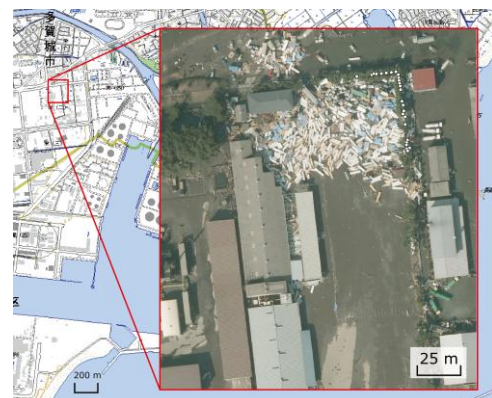
図-1 多賀城市栄付近における空中写真による並木の津波漂流物捕捉状況と並木の配置。図中の○は現地調査による並木配置を示す。
