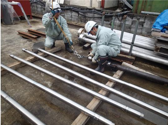
図3 製作した水圧破碎ツール(分割して平置きした状態)
