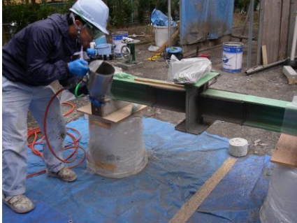
(a) ゴムラテックスモルタル施工状況
