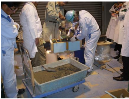
(b) 速硬軽量コンクリート打設状況
