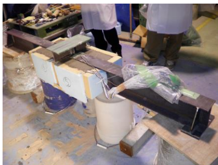
(c) 速硬軽量コンクリート打設後
