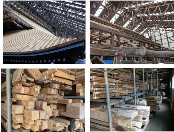
図3 歴史的建造物の修復工事(上2枚)において取り外された部材(下2枚)
