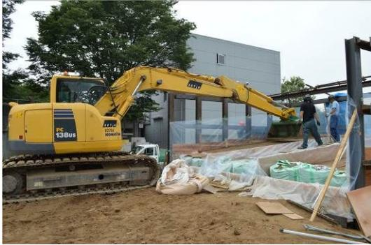
図 5 法面バケットによるキャピラリーバリア土層の試験施工
