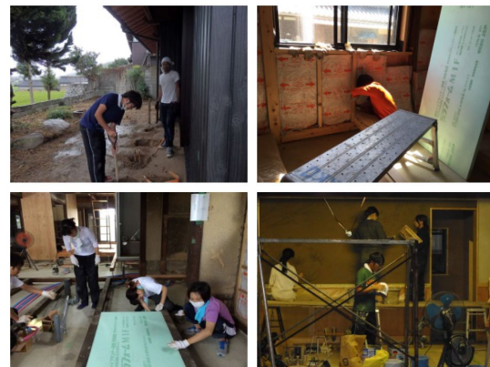
図4 学生が主体となった古民家の改修工事
