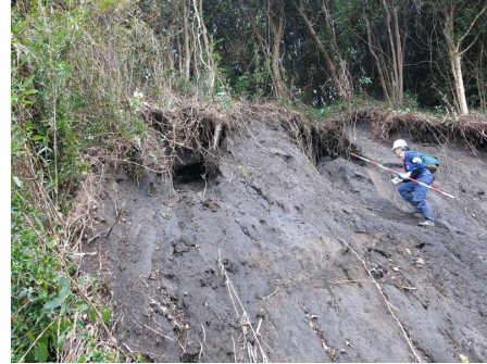
写真2 崩壊斜面の源頭部
