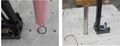
図 13 穿孔後の空隙及びとアンテナ挿入の様子
