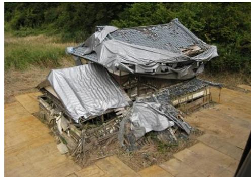
写真2 中越地震木籠水没家屋応急対応
