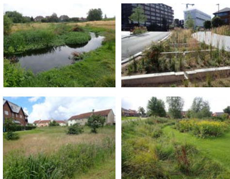
写真1(左上) 公園での河道付替と氾濫原創出
