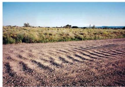
図-1 波状起伏が自然発生した未舗装路の一例 (D.C. Mays and B.A. Faybishenko, Complexity 5 (2000) 51より)
