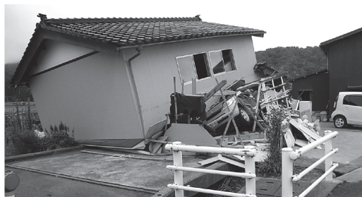
写真1 2層木造住宅の典型的な倒壊事例
