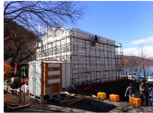
図 5. 中禅寺愛染堂の断熱覆屋
