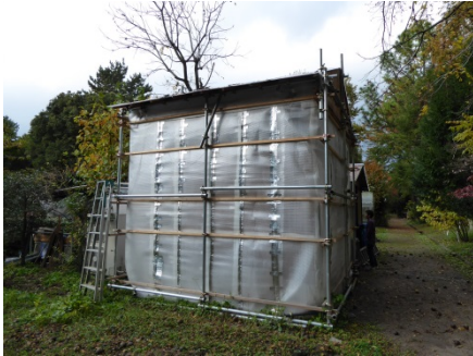
図 4. 試験用建物の断熱覆屋
