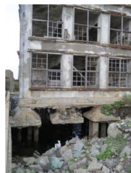
写真-1 護岸の変状事例
