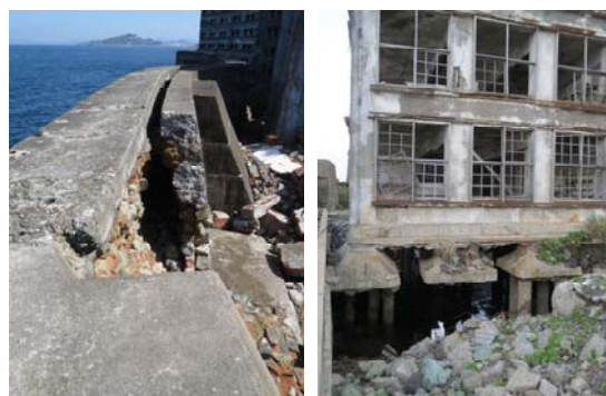
写真-1 護岸の変状事例
