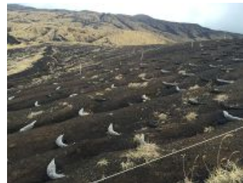
図 1 三宅島の火山荒廃地における三日月型治山緑化資材（東京クレセントロール工法）の設置状況
