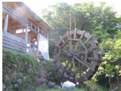
図5 小水力発電装置の修理
