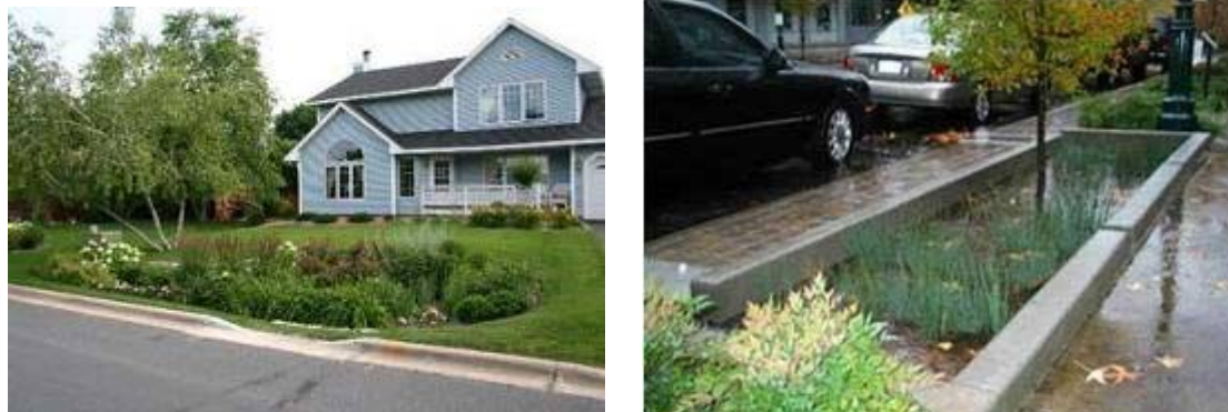
写真1 アメリカ合衆国環境保護局（United State Environmental Protection Agency : EPA）で紹介されているグリーンインフラストラクチャー。左はレインガーデン（Rain Gardens）、右は植栽柵（Planter Boxes）の例。
