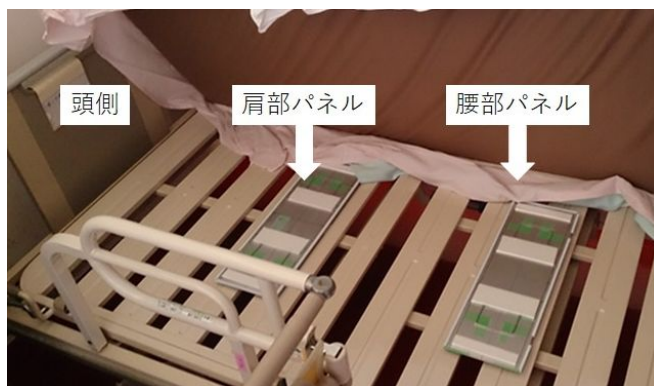
図2 体動検知パネルの設置状況
