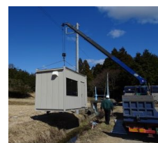
図6 自律運用・調査可能なシステムを収容するハウス
