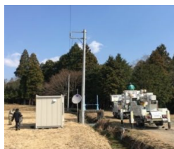
図7 電気工事の様子
