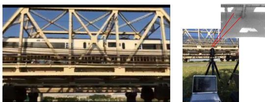
図10 電車通過時の橋梁と Visual-M3
