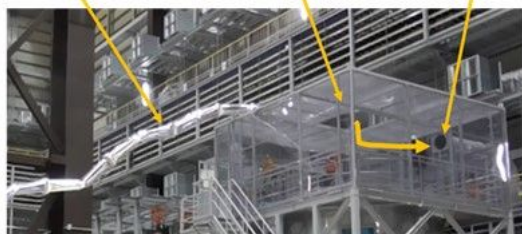
図 2 バルーン型長尺ロボットアーム(上:全景, 下: 建造物に接触しながらパイプにアプローチする 20m 長ジャコメッティアーム)
