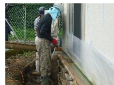
写真1 移転・再築された木造仮設住宅 (住田町)(筆者撮影) 写真2 木造仮設住宅のRC基礎改修工事 (阿蘇市)(熊本県提供)
