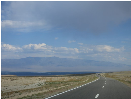
図 1 . 中国の烏魯木齊まで伸びる舗装道路
