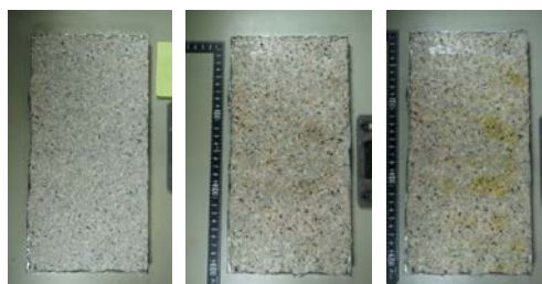
図10 花崗岩試験体の経時変化 (左から撥水材塗布前、塗布後、暴露2週間後)
