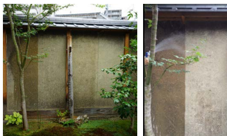
図11 土壁への撥水材施工と散水実験
