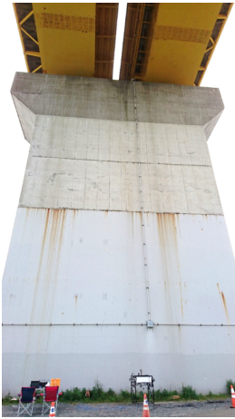
図3 点検を行った橋脚
