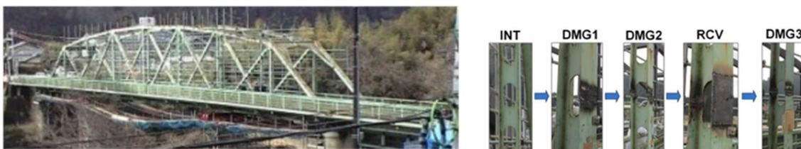
図 4-1-1 損傷実験橋梁と損傷シナリオ
