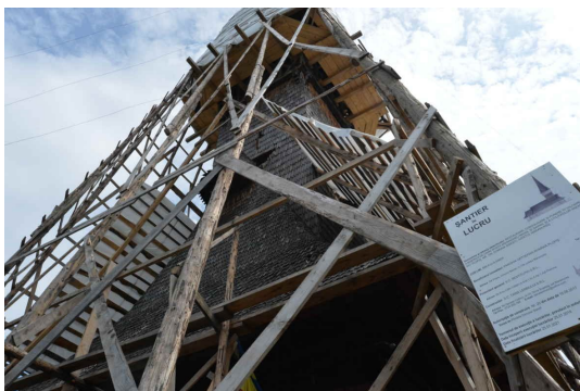
図 13. 修理中のプロピス教会堂
