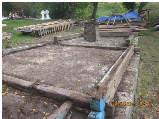
図5. 解体の状況 アンドリー氏
