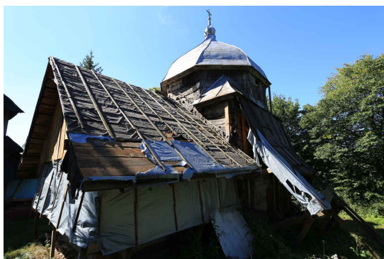
図3. ロニ教会堂修理前外観
