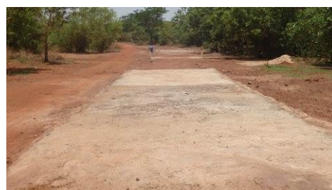
図7 路面かさ上げとコンクリート舗装
