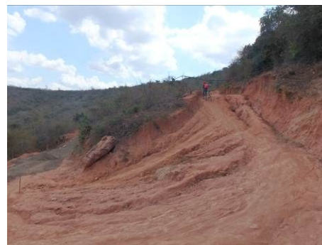
図 11 急カーブ部の施工前の様子
