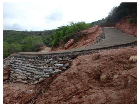
図 13 急カーブ部の施工後の様子
