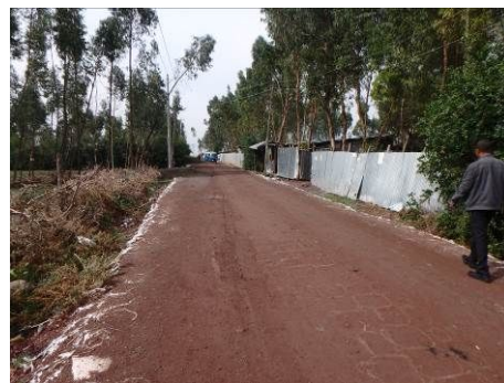
図5 土のう工法で整備され2年が経過した時の様子
