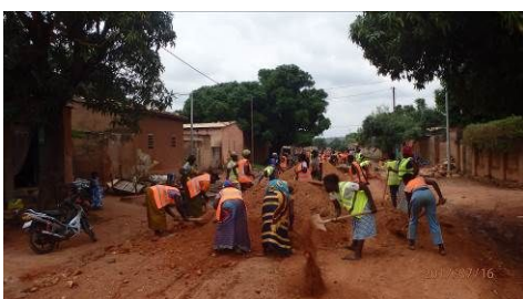
図8 都市部における道路整備の様子
