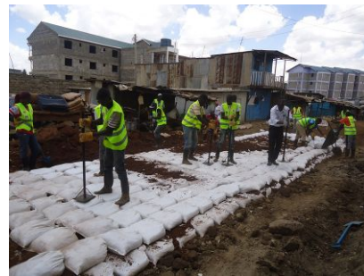
図3 若者への土のう工法の研修
