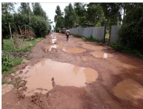
図4 膨張性粘性土地盤上の道路で土のう工法で整備する前の様子
