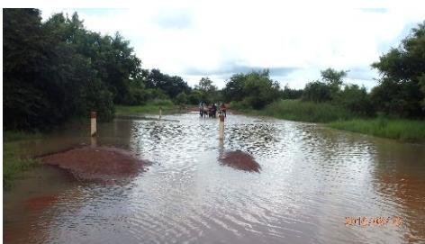
図6 雨季に水没する箇所
