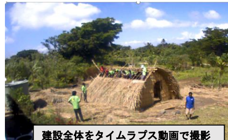
建設全体をタイムラプス動画で撮影 →建設工程ごとに工数を計測
